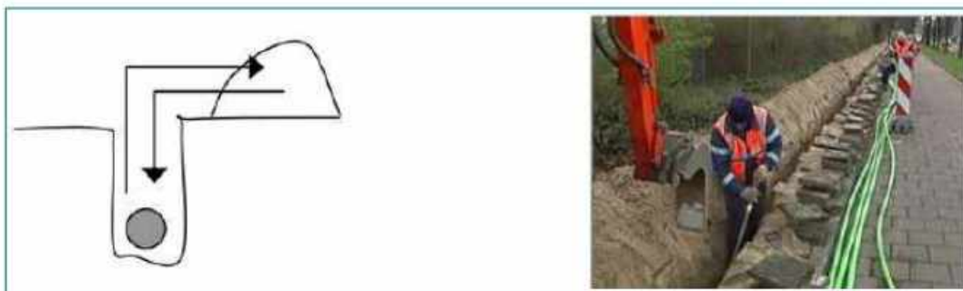
Figuur 9: werkzaamheden aan kabels en leidingen
