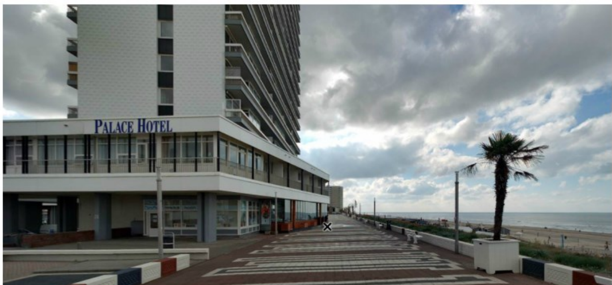
Foto 2 'kraag' volledig bebouwd in de 1 ste bouwlaag
