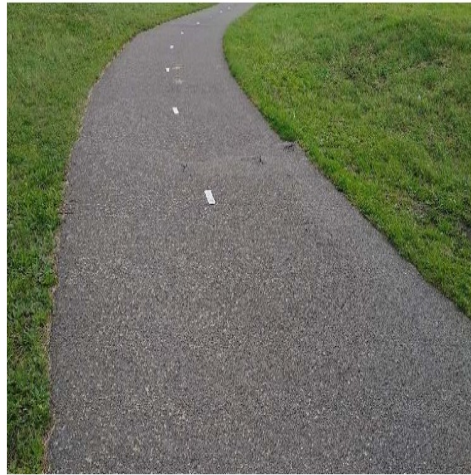
Foto 84 Verzakkingen in het asfalt
