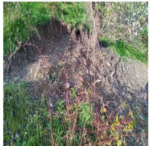
Foto 87b verschuiving in talud
