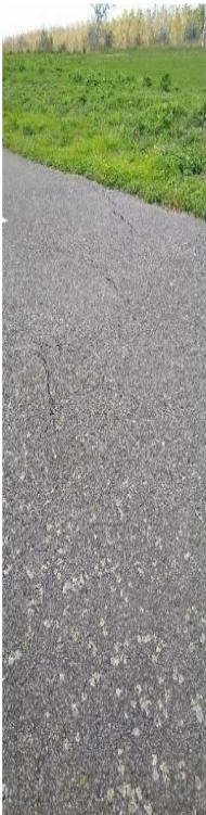
Foto 86 fietspad bobbels en scheuren
