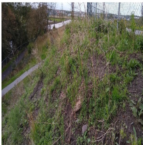
Foto 16 Blootligging talud welerbaan
