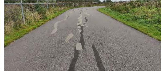
Foto 33: 53 scheuren wielerbaan gedicht
