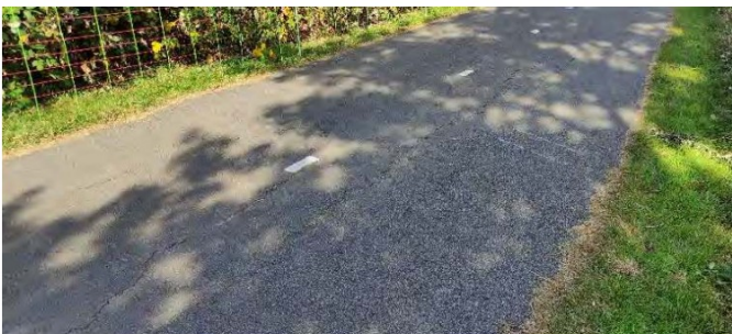
Foto 76: 165 scheuren fietspad
