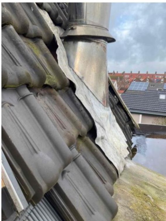
Rechterzijde zijgevel, er zijn openingen rond het lood aangetroffen. Het advies is om deze aan te kloppen.
