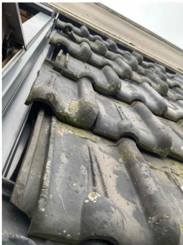
Er is een minimale ruimte langs het (Velux) dakraam geconstateerd.
