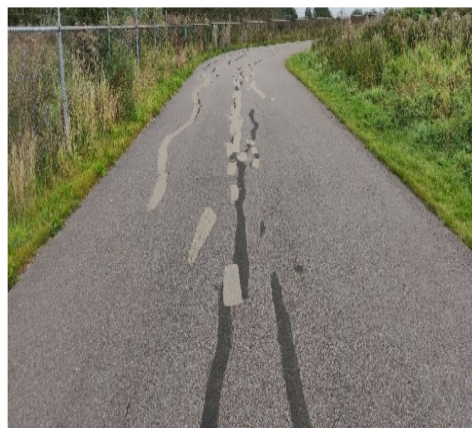
Foto 33: 53 scheuren wielerveen gedicht
