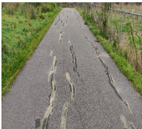
Foto 32: 52 scheuren wielerveen gedicht
